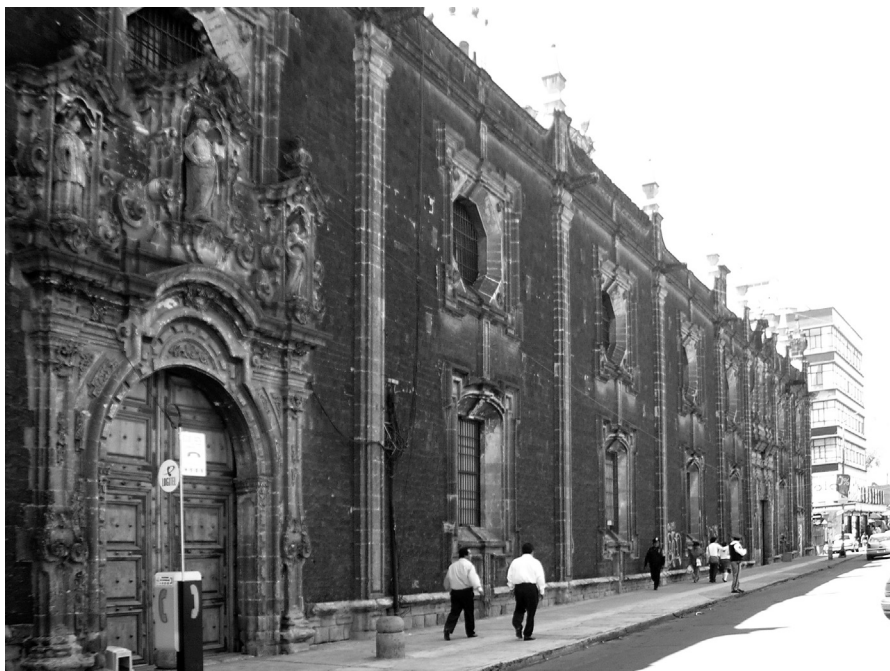
2. Fachada norte del Colegio de San Ignacio de Loyola “Las Vizcainas”. En primer plano, la portada barroca de la capilla hacia la calle. Fotografía: Iván San Martín (ISM), octubre 2006
