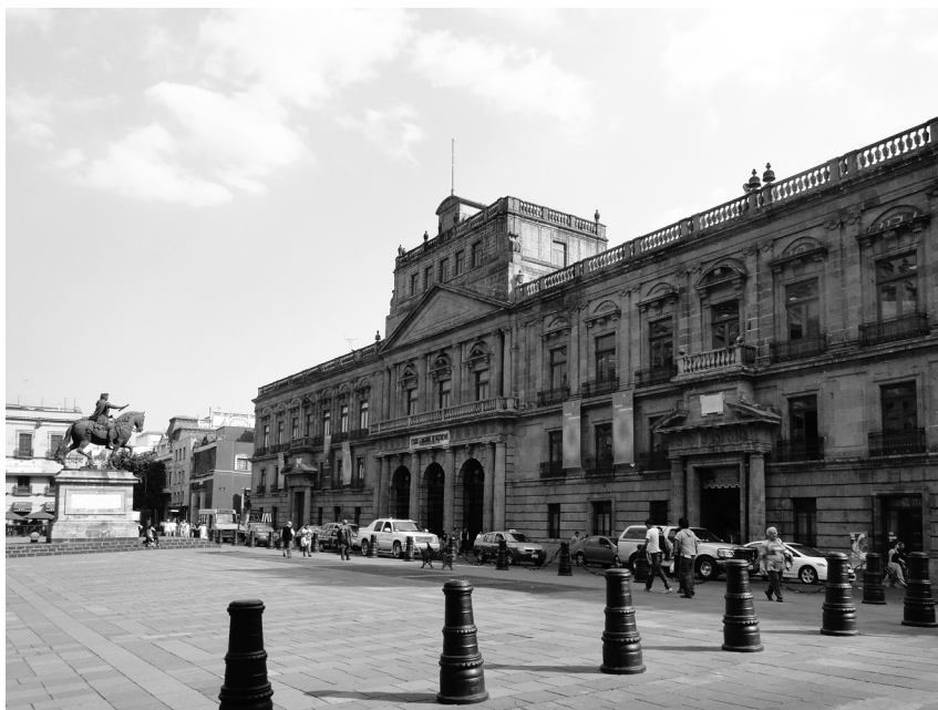
9. Fachada principal del Real Seminario de Minería. Fotografía: ISM, mayo 2011.
