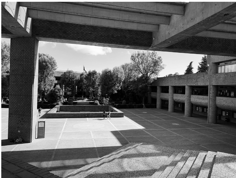
1. Patio central de la Universidad Iberoamericana (1984-88) en Santa Fe, Ciudad de México, del arquitecto Francisco Serrano. Fotografía: Lucía Santa Ana Lozada (LSL), febrero 2020.
