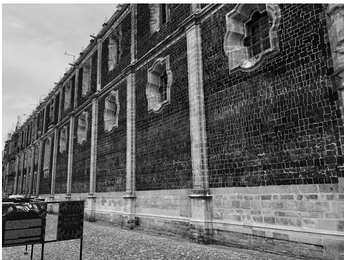
4. Fachada principal del Colegio de San Ildefonso. Fotografía: ISM, marzo 2020.
