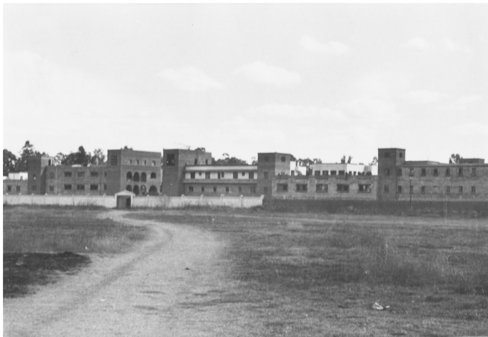
1. Fachada principal del Seminario Conciliar en construcción, ca. 1950. Fuente: Cortesía del Archivo de la Secretaria del Seminario Conciliar de Guadalajara.
